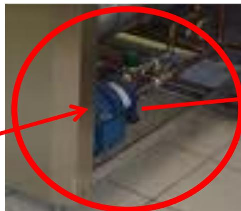
DETALHE DA BOMBA DE VÁCUO INSTALADA NA AUTOCLAVE SISTEMA DE VÁCUO
