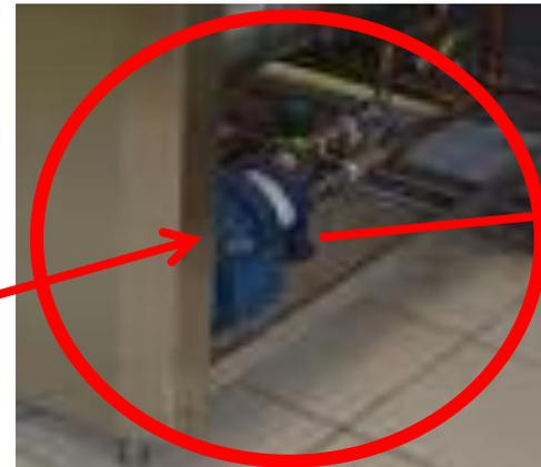
DETALLE DE LA BOMBA DE VACIO INSTALADA EN LA AUTOCLAVE
